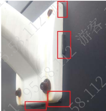
图2-2 增加减震垫
